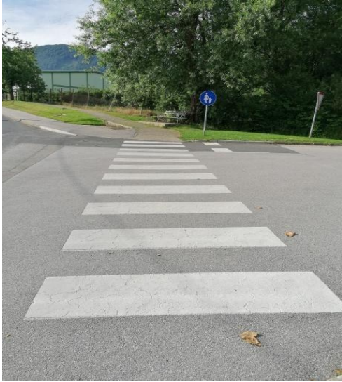
Slika 8: Označen prehod in steza za pešce (Šolska ulica).
