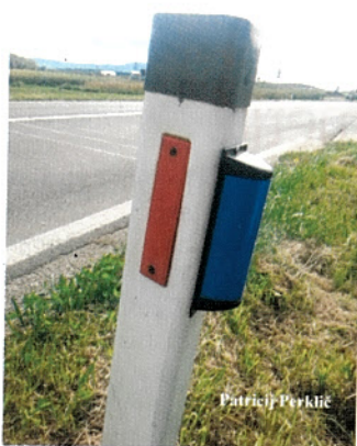
Modri svetlobni odsevniki imajo namen povečati varnost v cestnem prometu in s tem zaščititi voznike motornih vozil pred naletom divjadi v mraku in v nočnem času.
